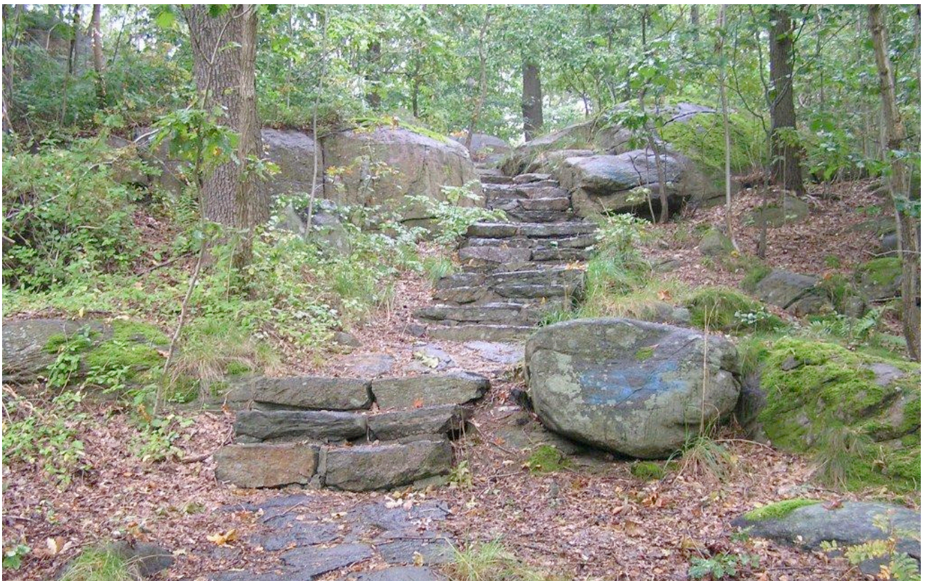
Bild 4. Dryga 200 trappsteg byggdes för att underlätta uppstigningen till Valåsens topp. James Jamesons intresse för vägar visade sig också i att han även var ordförande i gatu- och vägförvaltningen 1867-72.
